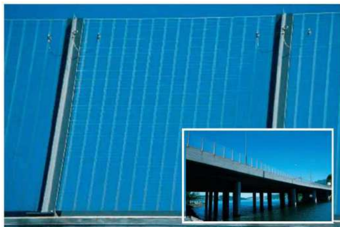
Figura 6.8 – Barreira acústica transparente ao longo de uma autoestrada na Suíça, com marcas verticais (luell, B. et al , (Eds.) 2003 in IP, 2021)
