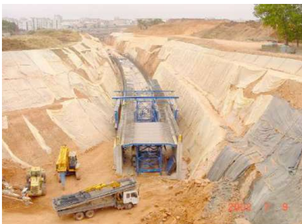
a) Escavação com taludes inclinados
