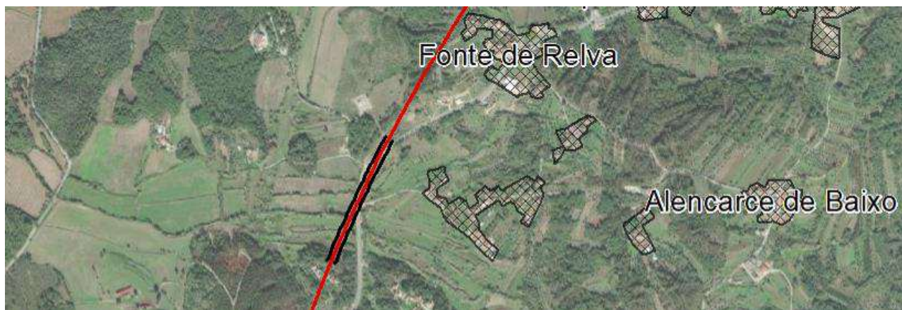
Figura 6.15 - Vista aérea da Ponte sobre o ribeiro da Milhariça (Eixo 1), onde é possível identificar a zona de várzea com manchas de produção agrícola fortemente compartimentadas sobre a qual a ocorrência se desenvolve, assim como o enquadramento fortemente marcado pela presença de manchas associadas à produção florestal e as principais povoações afetadas visualmente. (Fonte: produzido em ArcMap)
