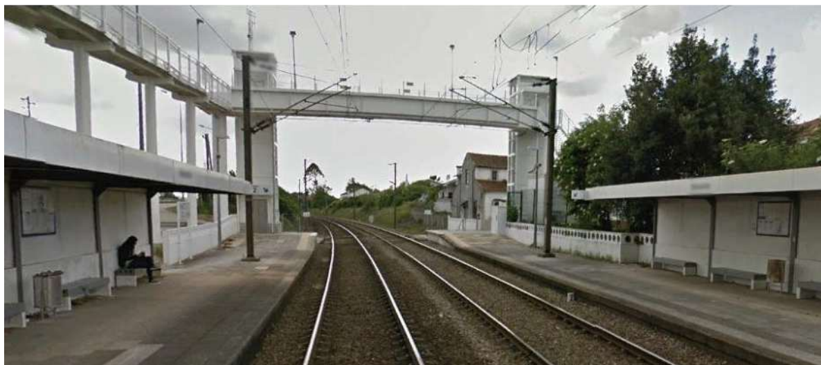
Fotografia 3.18 – Apeadeiro de Bencanta – passagem superior de peões a substituir
