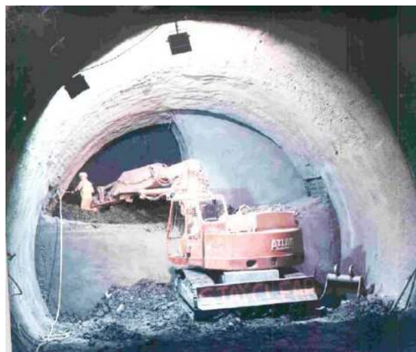
Fotografia 3.14 – Método de escavação NATM
