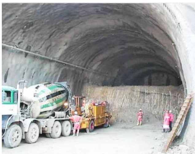
Fotografia 3.14 – Método de escavação NATM
