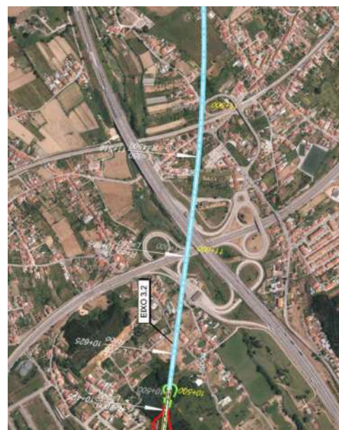
Figura 4.112 – Passagem dos Eixos 3.1 e 3.2, em ponte, em Ribeira de Frades e São Martinho do Bispo
