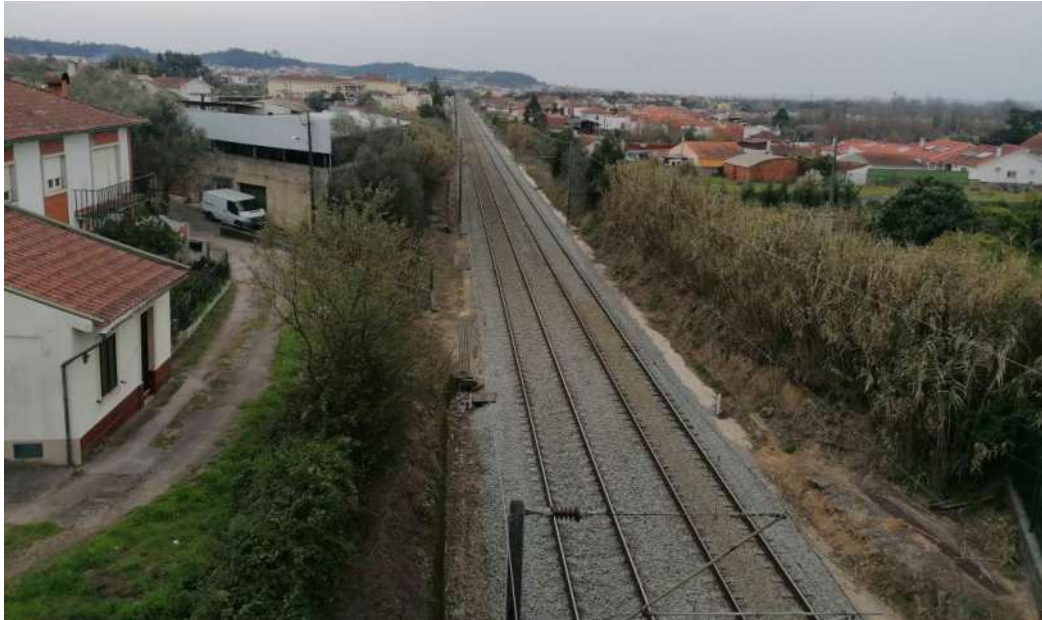
Fotografia 3.7- Ocupação urbana adjacente à linha do Norte no trecho a quadruplicar
