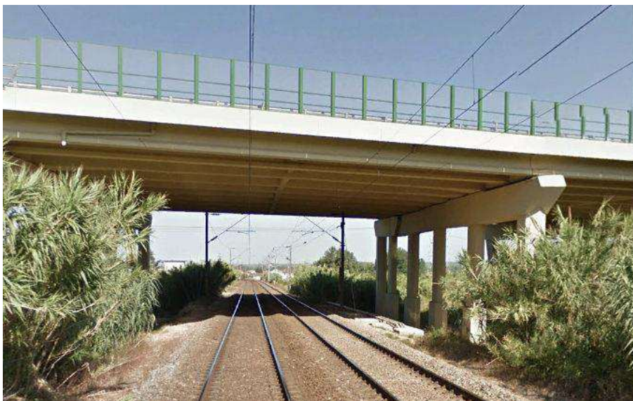
Fotografia 3.21 – Vista da PSR (A1) ao pk 212+140 no sentido decrescente da quilometragem
