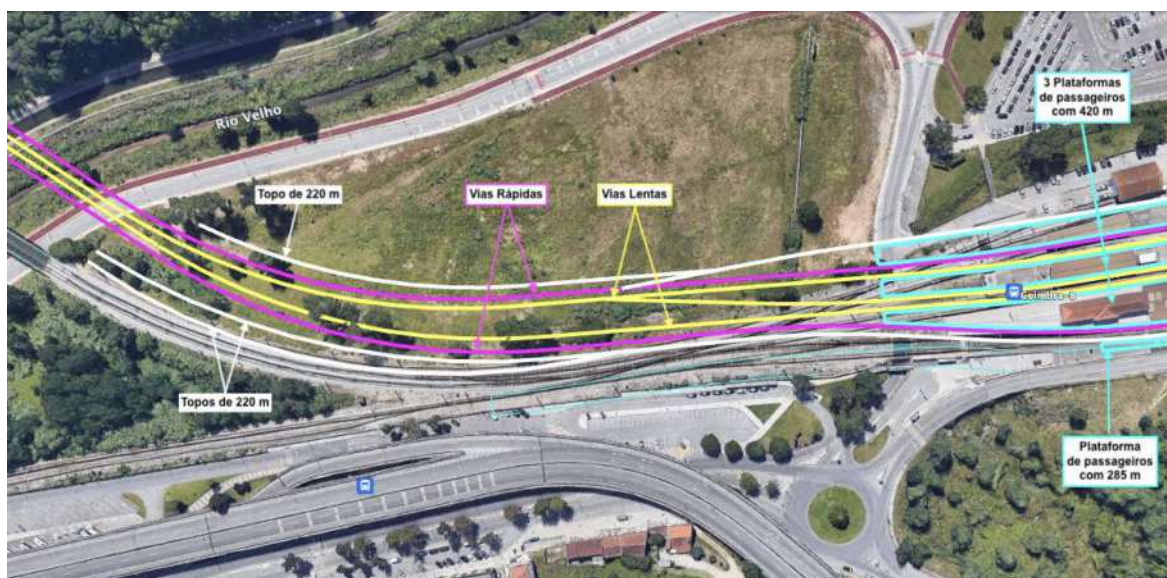
Figura 3.51 – Estação de Coimbra: vias a sul das plataformas de passageiros
