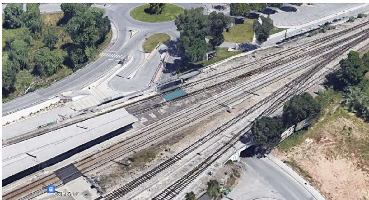
Figura 3.61 – Vista da PIR ao pk 217+136 da VA Rápida, a sul da Estação de Coimbra B
