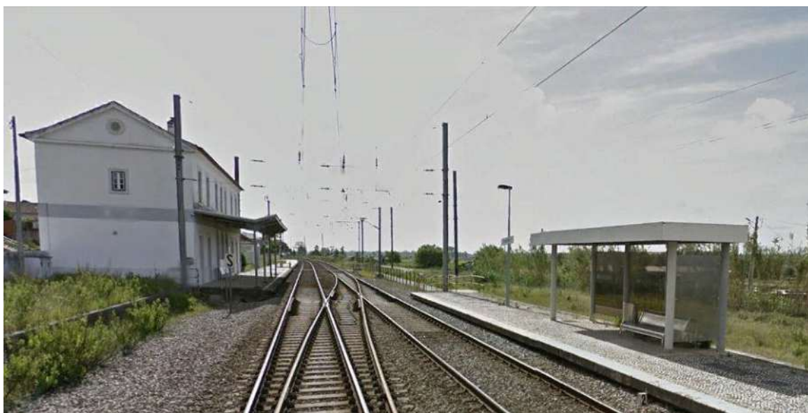
Fotografia 3.15 – Estação de Taveiro - Edifício de passageiros
