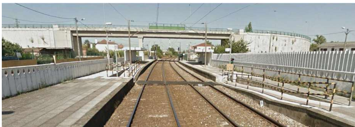
Fotografia 3.16 – Apeadeiro de Casais- passagem de nível de peões a eliminar
