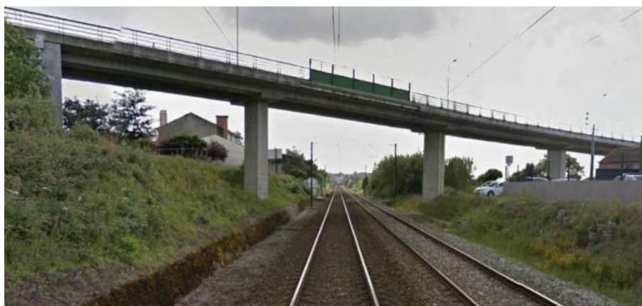
Fotografia 3.23 – Vista da PSR ao pk 214+450 no sentido decrescente da quilometragem
