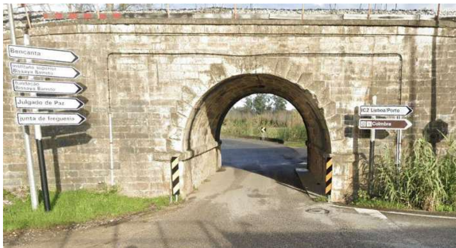
Fotografia 3.25 – Vista da PIR da Rua da Quinta Agrícola ao pk 215+935
