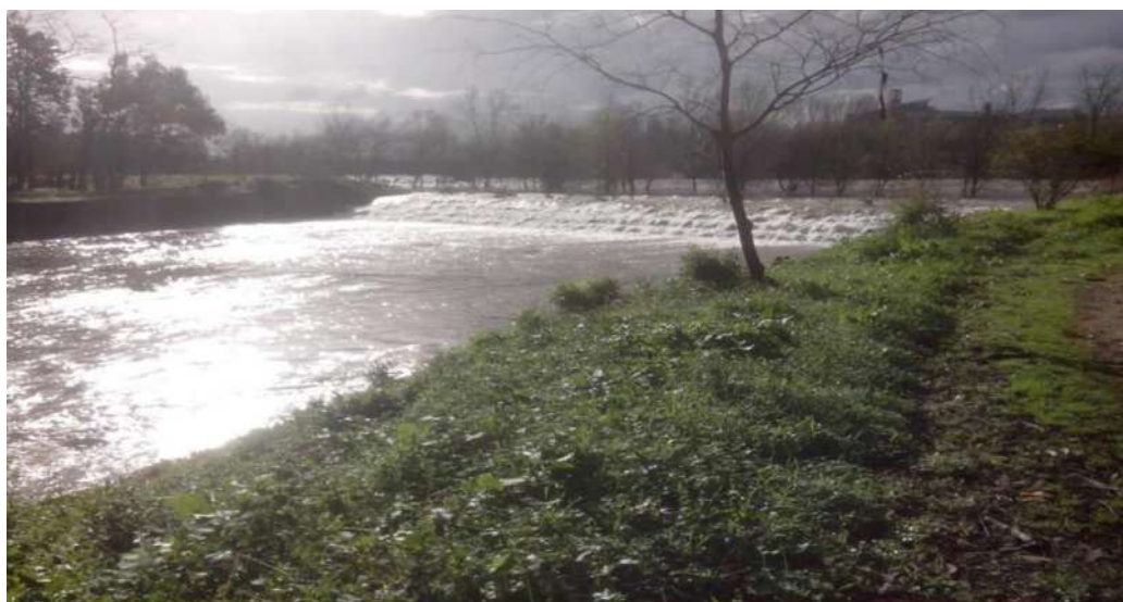
Fotografia 6.1 – Descarregador fusível do Choupal (cheias de 2016) (Fonte: “Aproveitamento hidráulico do Mondego e a Redução do Risco de Inundação do Baixo Mondego”, José Manuel Proença)
