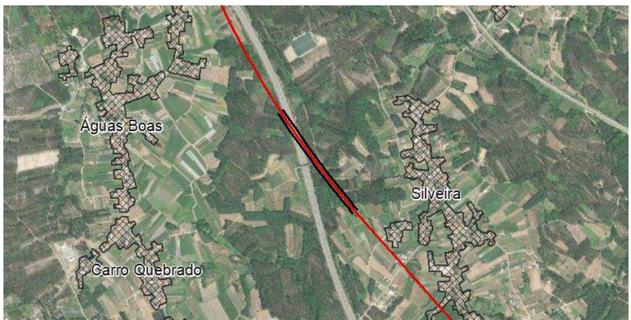
Figura 6.42 - Vista aérea da zona onde ocorre o Viaduto sobre a A1/IP1 entre o km 8+225 e o km 8+864 da Variante de Oliveira do Bairro (V.OB.2), sendo possível identificar predominância de manchas associadas à produção agrícola e silvícola, assim como as principais povoações potencialmente sujeitas a elevados níveis de intrusão visual na envolvente. (Fonte: produzido em ArcMap)
