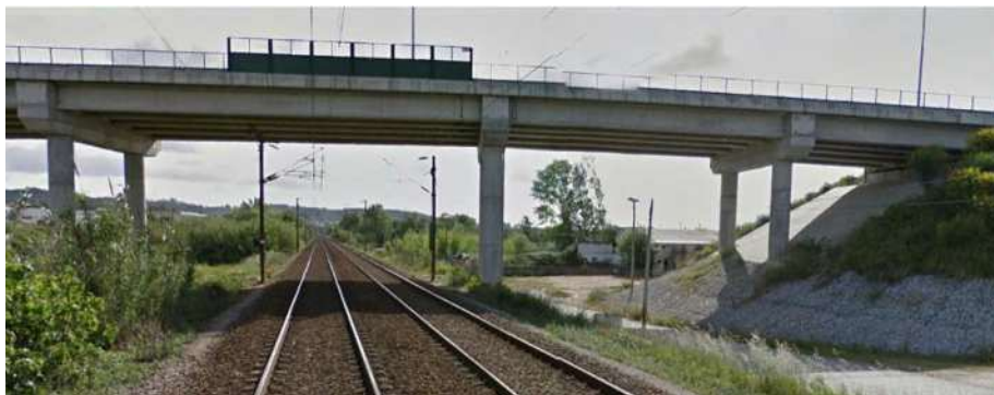
Fotografia 3.19 – Vista da PSR ao pk 210+265 no sentido decrescente dos km
