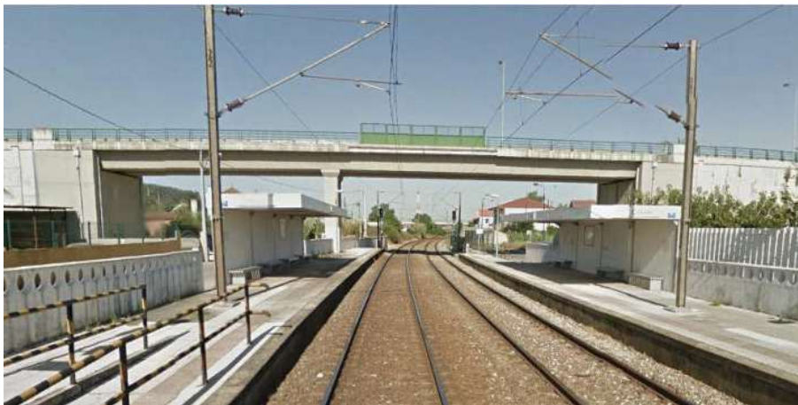
Fotografia 3.22 – Vista da PSR ao pk 212+538 no sentido decrescente dos km
