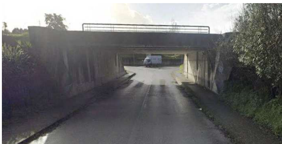
Fotografia 3.24 – Vista da PIR ao pk 213+258 a partir da via inferior
