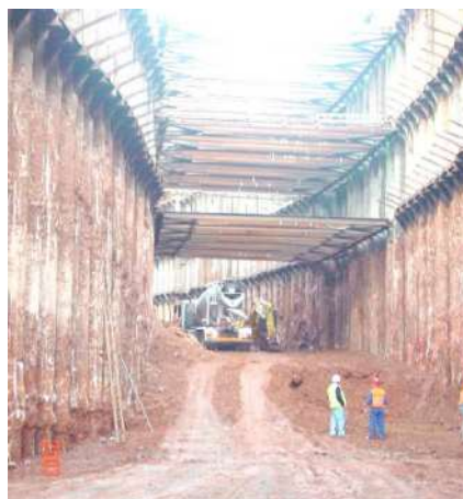
b) Contenção por estacas
