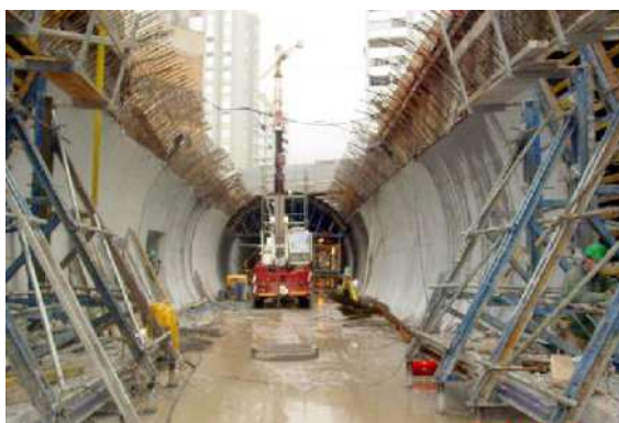
d) diretriz circular, em betão armado betonado “ in situ ”
