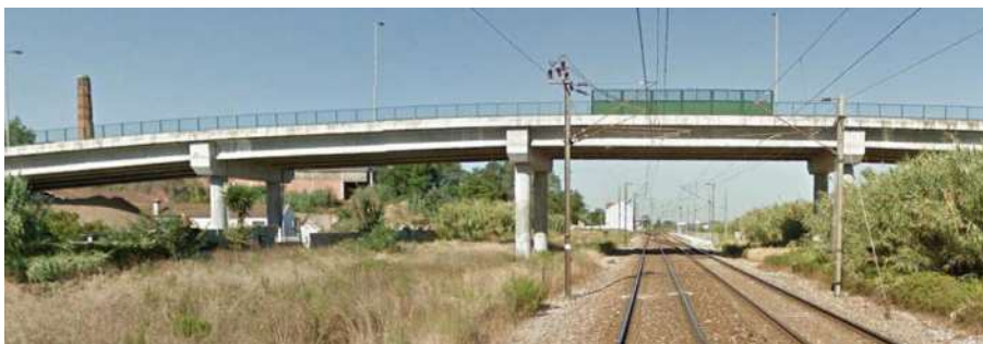
Fotografia 3.20 – Vista da PSR ao pk 211+328 no sentido decrescente da quilometragem
