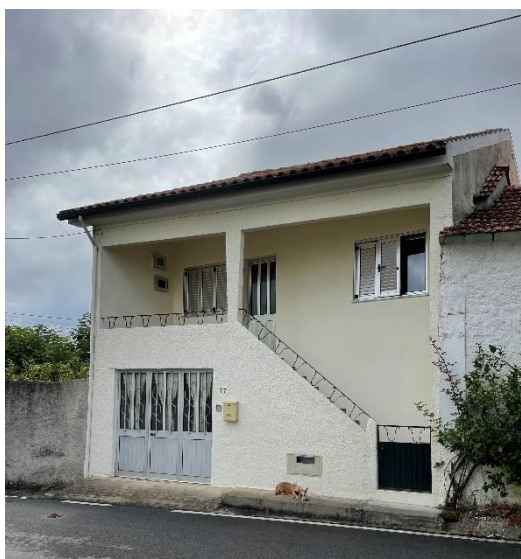
Figura 33. Cobertura com beirado e caleira
