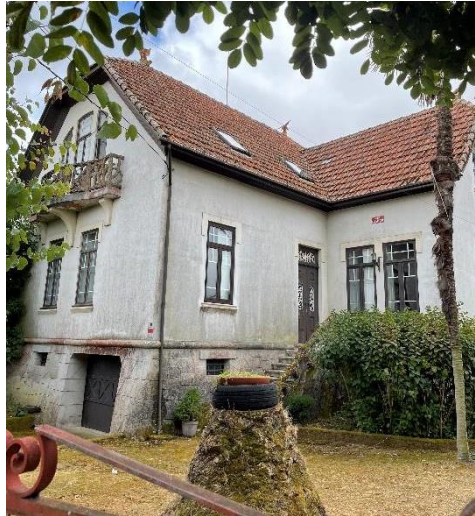
Figura 14. Edifício relevante na Rua Dr. Joaquim da Silveira
