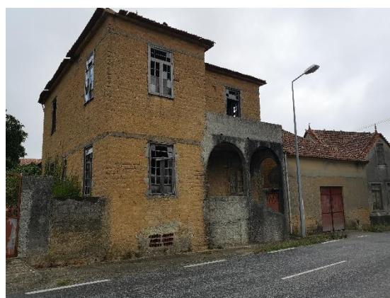
Figura 40. Caixilharias degradadas
