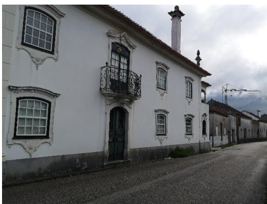
Figura 12. Edifício relevante na Rua Dr. Joaquim da Silveira
