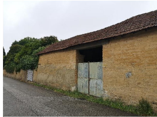
Figura 34. Cobertura deformada
