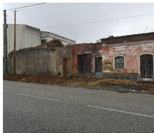
Figura 35. Cobertura colapsada
