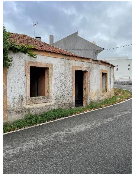
Figura 41. Edifício sem caixilharia
