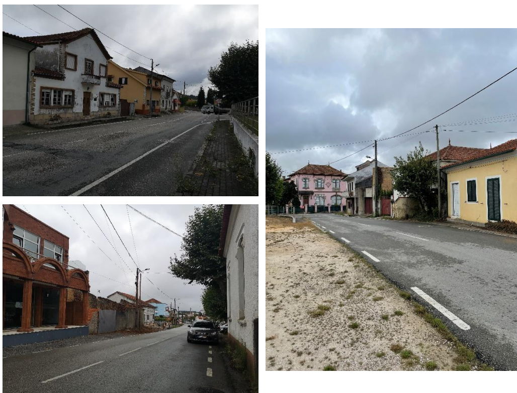
Figura 1. Exemplos da estrutura viária da Fogueira
